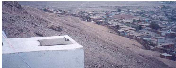
Fig. 3.- Casas en taludes
